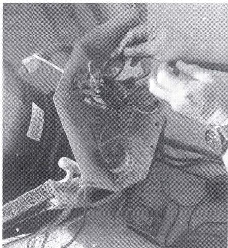
Reparaciones en el evaporador, se le cambio el capacitor de arranque del motor del compresor, conectores, y se le coloca un tope al eje del ventilador.
